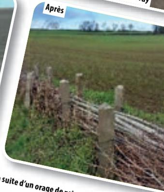
Fascine posée à Blacourt en 2021 à la suite d'un orage de printemps
